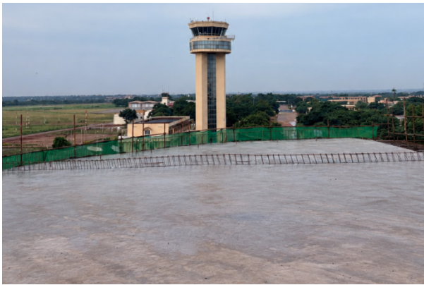
图3 屋面混凝土浇筑成型效果
