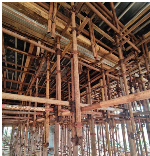
图2 模架顶层步距立杆搭接加固现场应用
