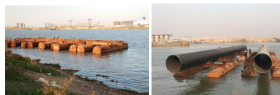
图 4.2-1 可控浮箱、浮运示意图
