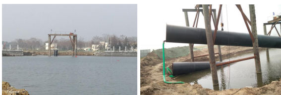
图 4.3-5 钢管沉放、水压试验示意图
