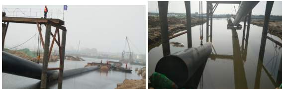
图 4.3-4 钢管整体吊起沉放示意图
