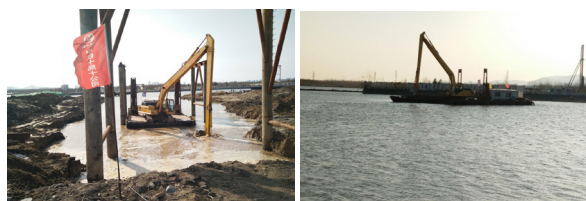
图 4.1 挖机水上施工用装配式作业平台示意图
