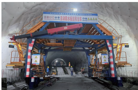
图1 防水板挂布台车机器人整机结构
