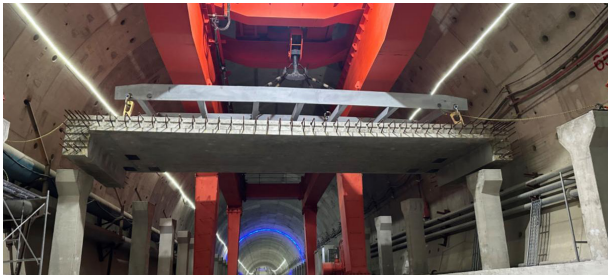
传统桁车工艺吊装预制车道板
