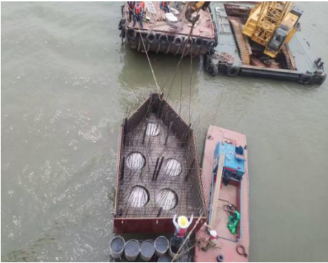
图2 钢管桩防撞墩
