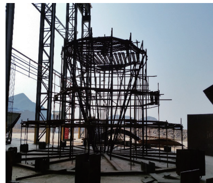
图 4-3 拼装脚手架
