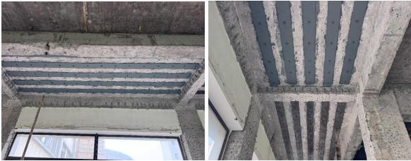
图4 粘钢加固照片
