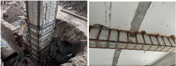
图3 外包型钢加固照片
