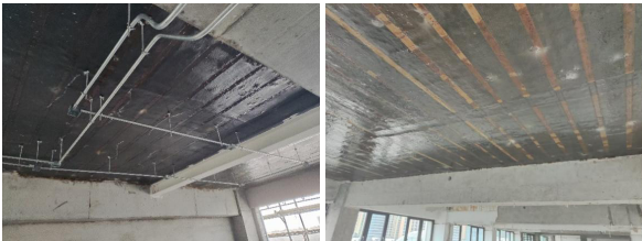
图5 碳纤维加固照片
