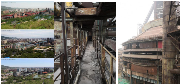
图11 三高炉改造前样貌 网络
