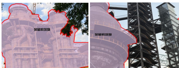
图16 保留构筑物——热风炉 自绘 图17 保留构筑物——重力除尘器 自绘
