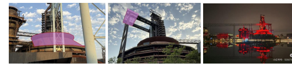
图8 替换原有罩棚板 自摄 图9 观景平台 自摄 图10 三高炉夜景 自摄
