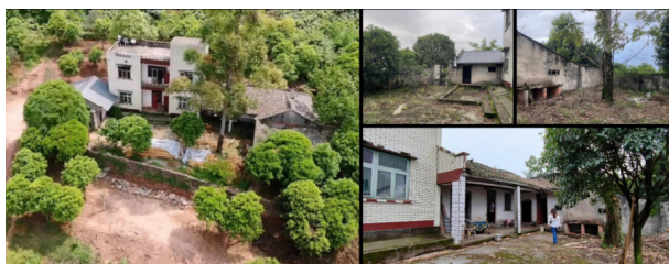
图1：改造前现场状况
