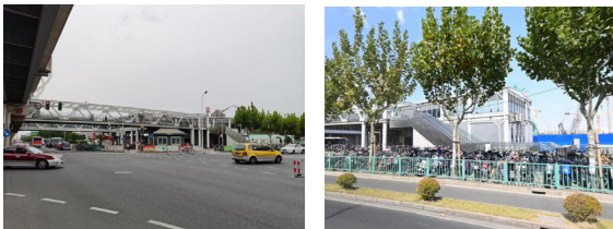
图6：原巨峰路站1号出入口及换乘通道地面
