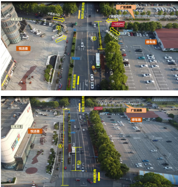
图8 富康路至新城路交通现状(改造前)
