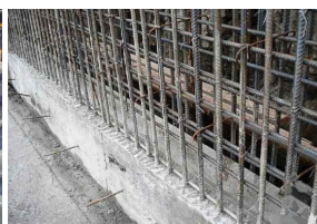
图3 地下室外墙+300设置止水钢板图
