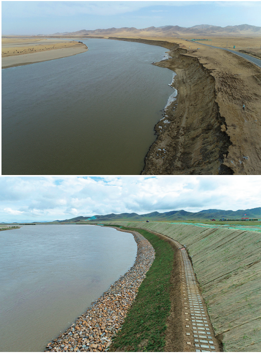
黄河干流若尔盖段应急处置工程建成前 工程建成后河岸得到有效加固、水土流失明显改善
