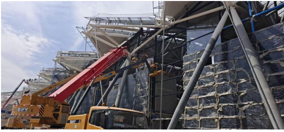
图2 精致钢框架幕墙玻璃安装图
