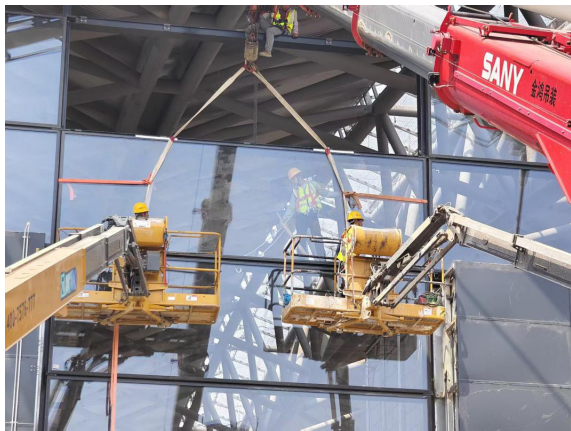
图3 精致钢框架幕墙玻璃安装图
