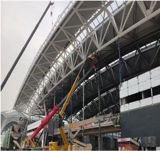
图2 精致钢龙骨安装
