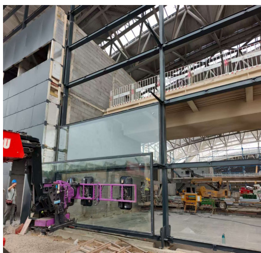
图3 幕墙玻璃安装
