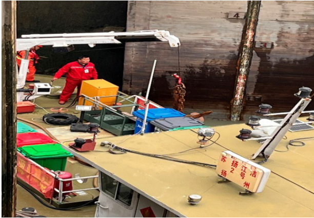
图1 闸门轨道捞锚作业
