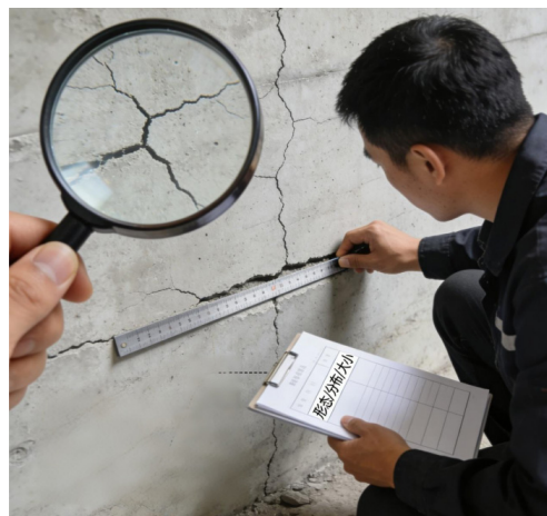
图1 裂缝排查
