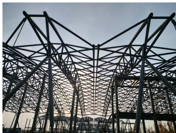
图8 屋面钢桁架提升后现场图
