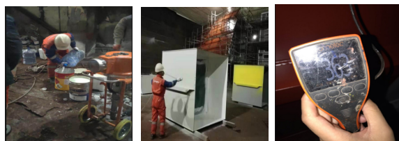
水性漆加水稀释 无气喷涂 测试干膜厚度
