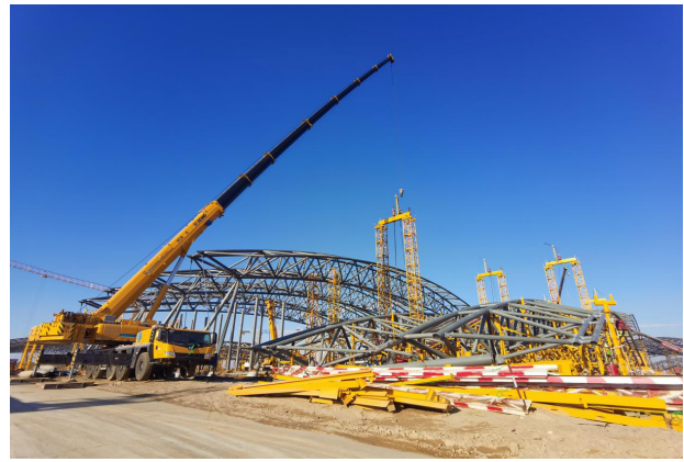
图12 施工现场提升架及提升设备安装
