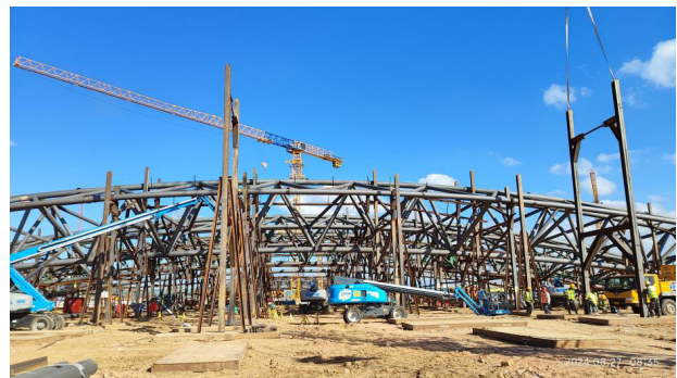
图10 施工现场胎架拼装
