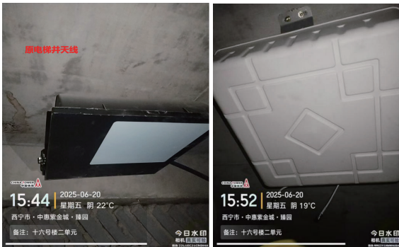
图3左：原增益15dBi电梯天线；图3右：替换后增益20.5dBi超材料天线
