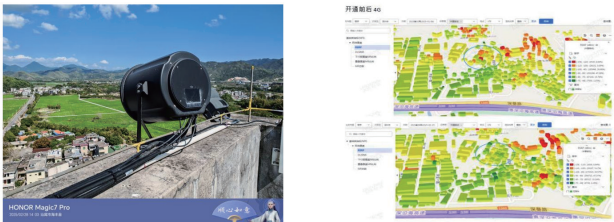
图3 赤石社区站点建设前后覆盖对比图
