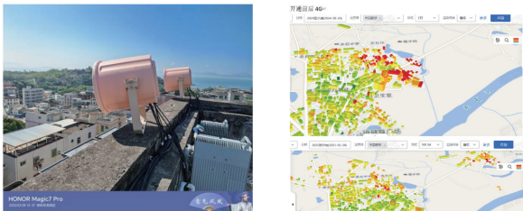
图4 土洋村北站点建设前后覆盖对比图
