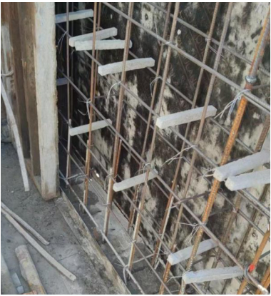
图6 放置混凝土撑块
