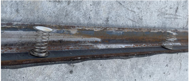
图2 密封条安装
