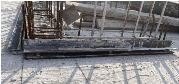
图5 密封装置安装固定
