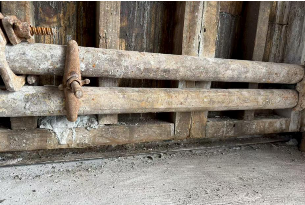
图9 浇筑完成后底部无漏浆
