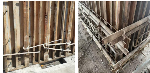
图7 定型模板安装
