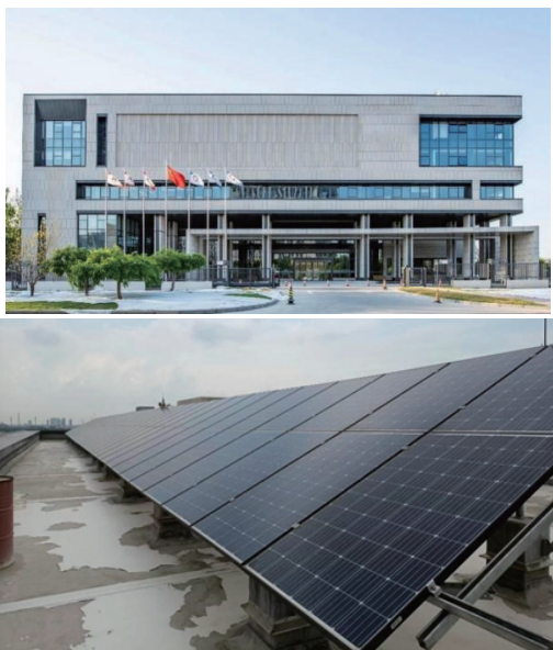
图2建筑及屋面光伏组件安装实景
