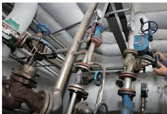
图3 管道试压现场图
