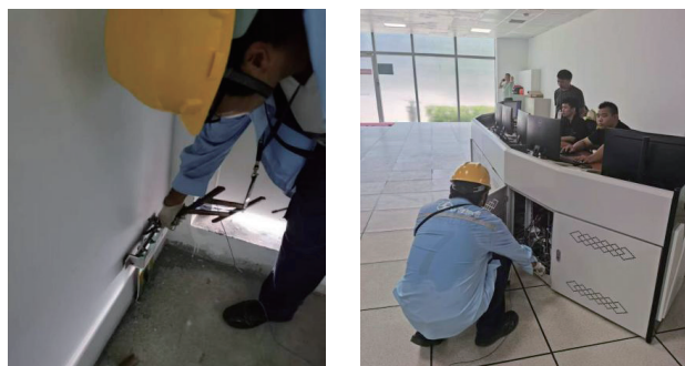
> 图3 室内检测现场
