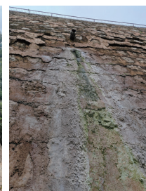
> 图12 泄水孔下方结晶情况
