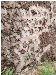
> 图9 拦渣坝侧面开裂照片图
