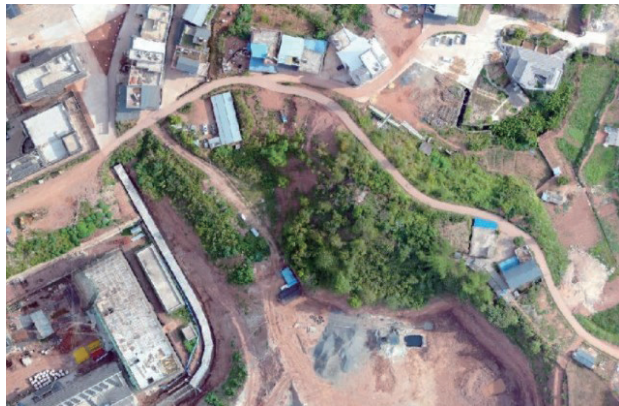
> 图1 治理前边坡实景图
