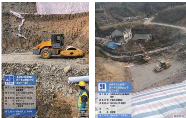
> 图2 碾压压实施工
