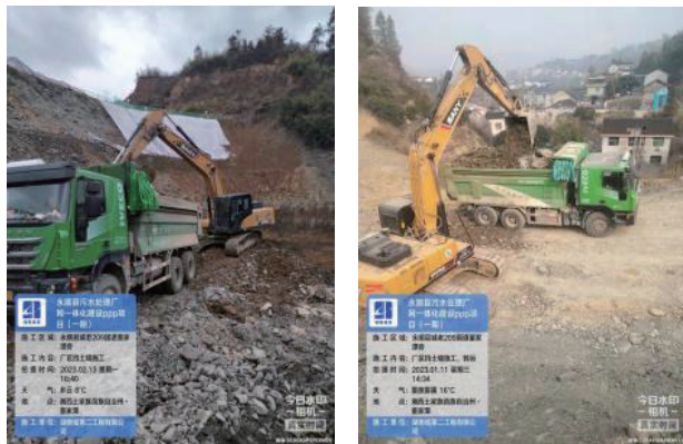
> 图1 边坡开挖及转运
