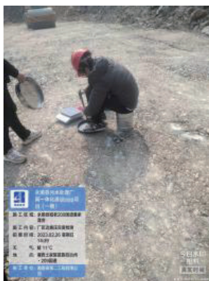
>图7 压实度检测
