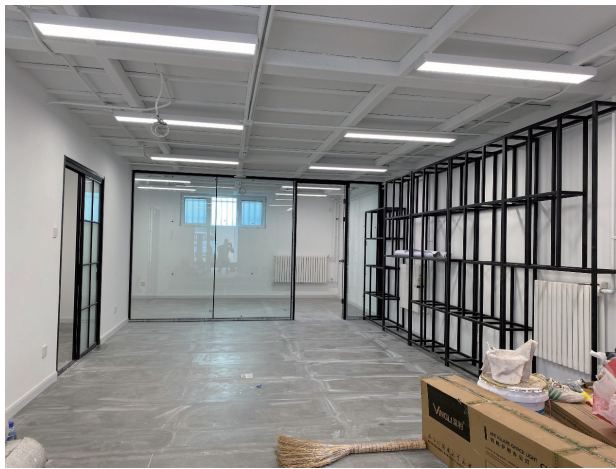
> 图一：钢结构夹层改造施工
