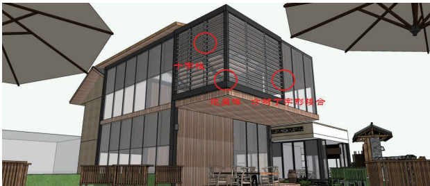
> 图3 榫卯结构应用实例
