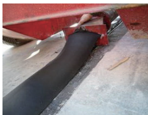
图7 填料挤出成型
