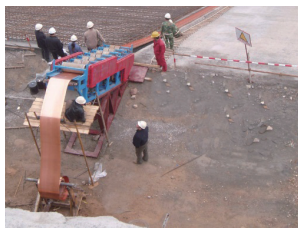
图2 止水铜片加工图
