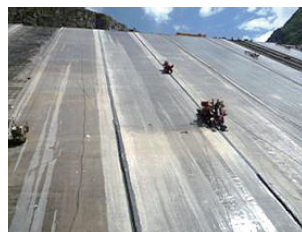
图6 止水机械化施工
