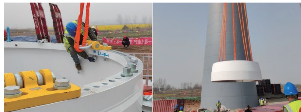
> 图9钢过渡吊装
