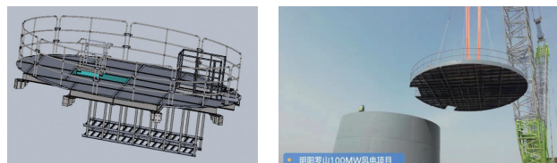
> 图5防护平台安装
