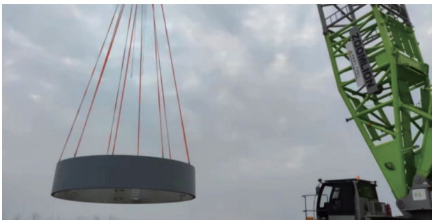
> 图2首节塔筒吊装
