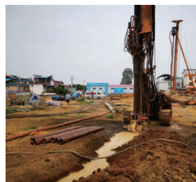
> 图3 普通抗浮锚杆双管成孔
