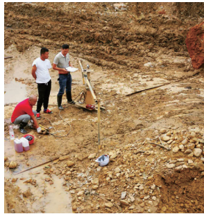
> 图11 普通抗浮锚杆基本试验
