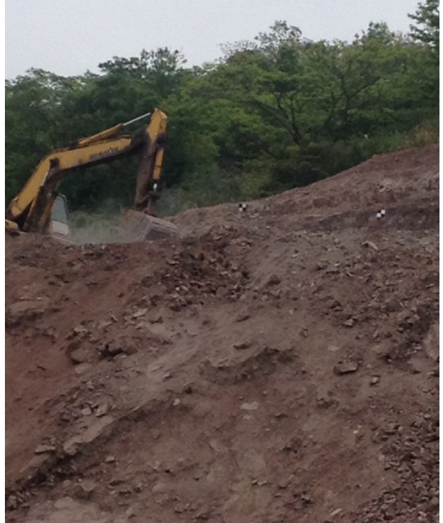
> 图 4 工程应用中多目标靶板安装图
