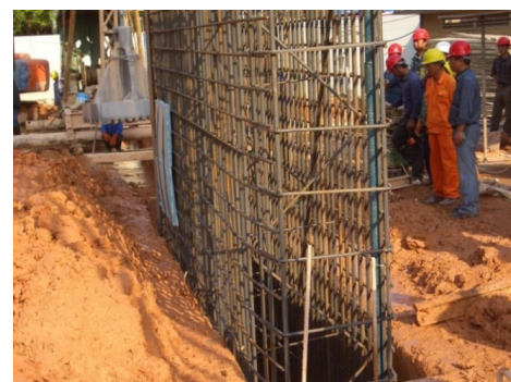
> 图2 钢筋网片入槽
