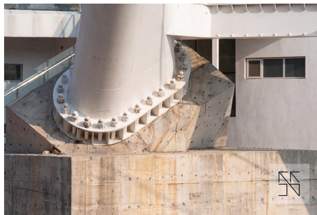
图 1 拱脚处主拱圈增加截面
