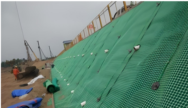
> 图1 绿色装配式护坡 GRF 板
