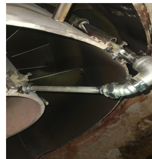
> 图4 安装好的保护套管
