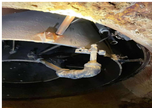
> 图5 改造两年后壁温元件照片
