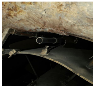
> 图1 壁温测温热电偶原始安装路径
