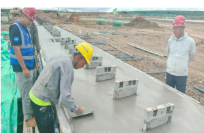
浇筑混凝土
