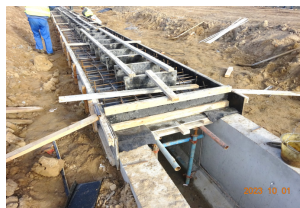
钢筋、泄水孔模板安装完成
