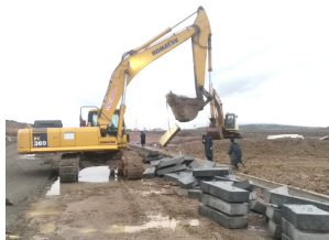
预制盖板吊装
