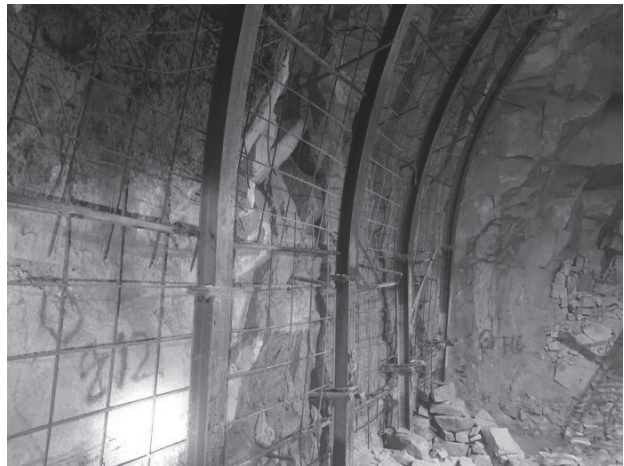
图 3.4.2-2 现场施工设立钢拱架
