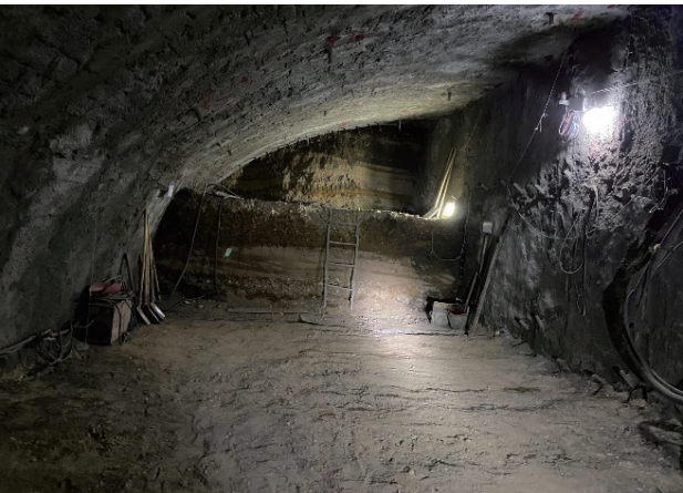
>图3 1号洞室开挖现场图
