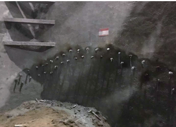
>图2 马头门加固示意图
