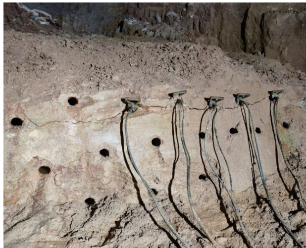
>图6 现场劈裂作业图
