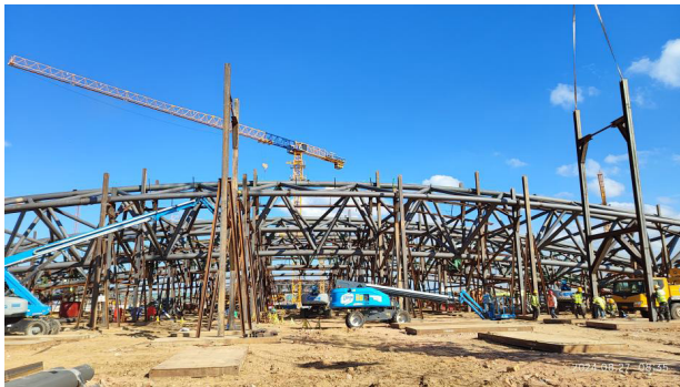
图10 施工现场胎架拼装
