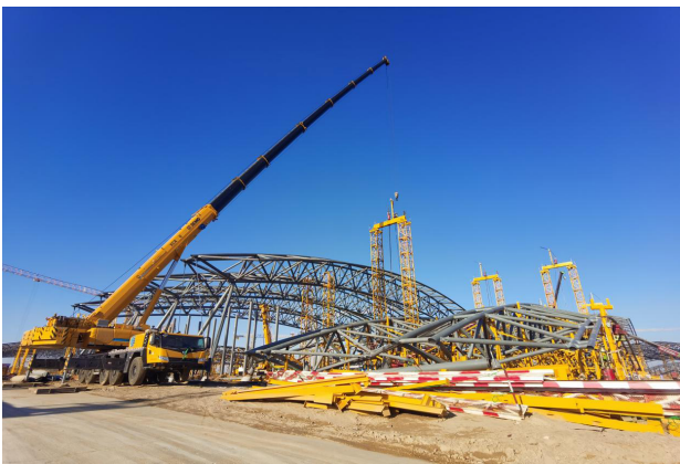
图12 施工现场提升架及提升设备安装
