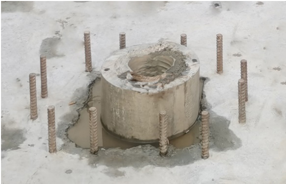
图2 预埋锚筋布置实景图
