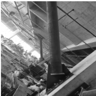
图11 斜拉杆与二层混凝土柱连接节点
