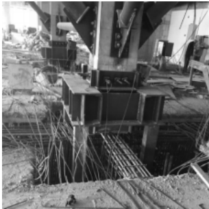
图9 围套和斜拉杆远景照片
