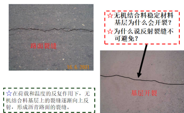
图1 反射裂缝
