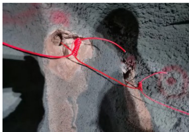
图8 导爆索“T”型链接
