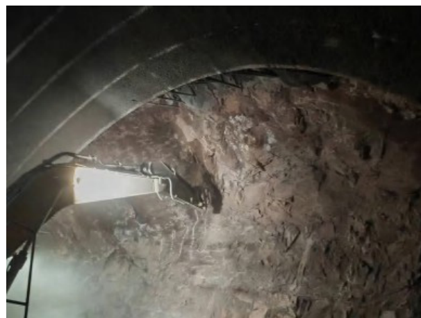
图9 光爆前排险后超欠挖严重
