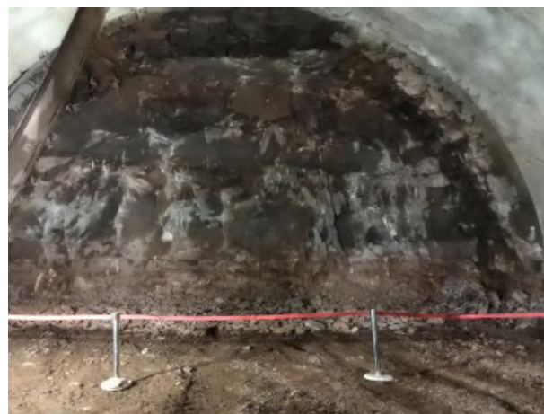
图10 光爆后排险后无超欠挖
