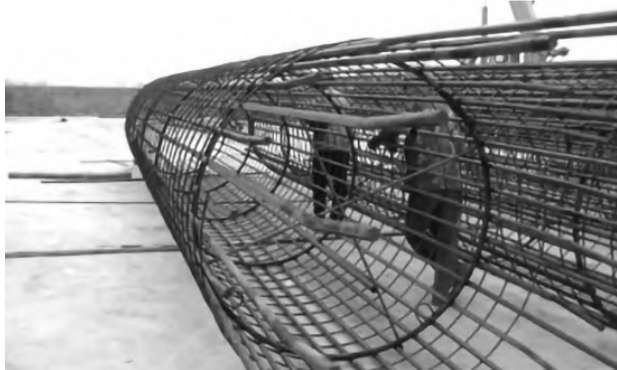
图2：钢筋笼制作现场
