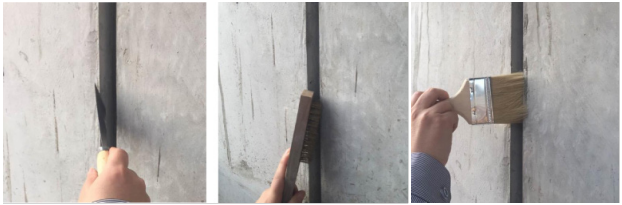
> 图1 接缝处理过程
