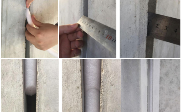
> 图2 背衬材料和美纹纸胶带过程
