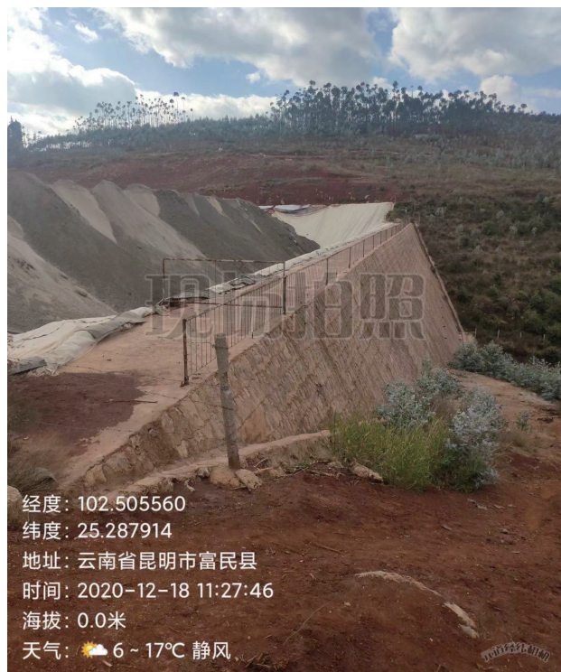
> 图7 磷石膏废渣回填过程照片
